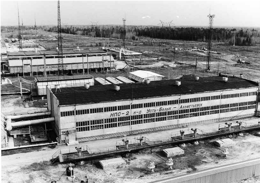
НПС – 2 магистрального нефтепровода Усть-Балык – Курган – Уфа – Альметьевск.
