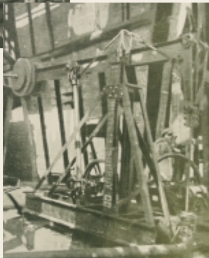
Американские станки-качалки на промыслах Баку (из журнала «Нефтяное и сланцевое хозяйство»)
