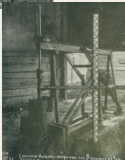
Трактор Франклина и качалка с выпрямителем Джансона (из журнала «Нефтяное и сланцевое хозяйство»)
